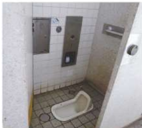
▼北区公園内の公衆トイレの例
